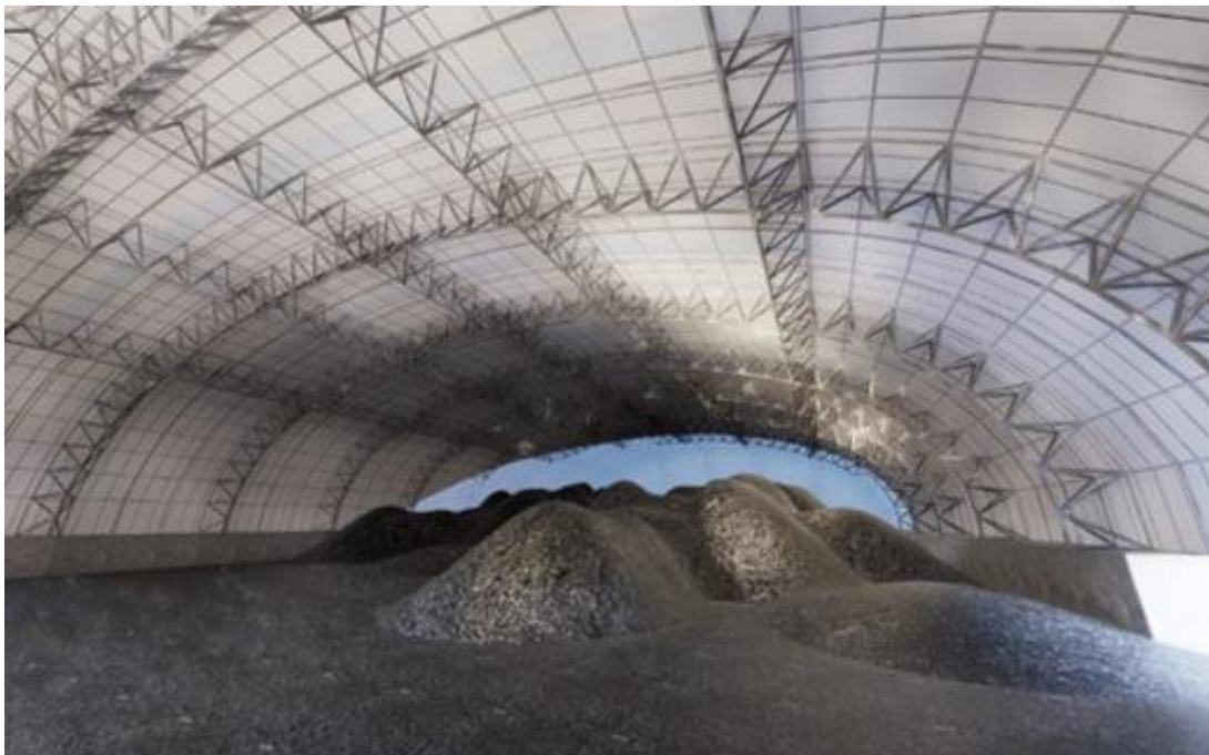
弧形网架结构
